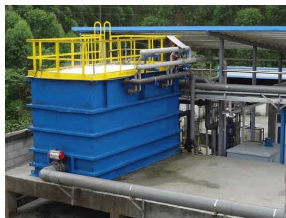
Fotografía 2: Bioreactor de membranas con membranas sumergidas de 60m 3 /hr de capacidad instalada en China.
